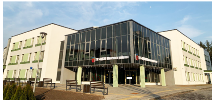
Социальный центр в Боровлянах
